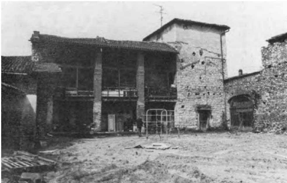
Antica torre del castello Marenzi, con adiacenze rurali in via Torre, come appariva prima dei recenti restauri e rifacimenti.
