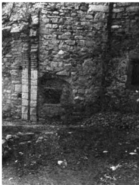
Un altro particolare del castello Marenzi.
